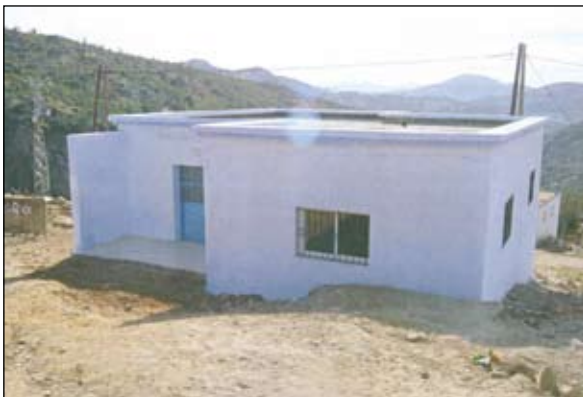
مبنى الحجرات الدراسية - منطقة الزاوية منطقة شفشاون - المغرب
